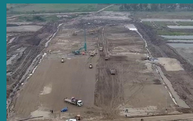
Công trường Dự án Project construction site
