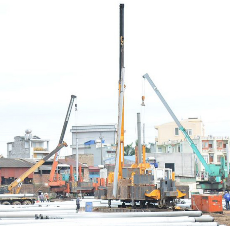
Thi công ép cọc ly tâm tại Dự án Việt Phát South City Viet Phat South City Project pile pressing construction
