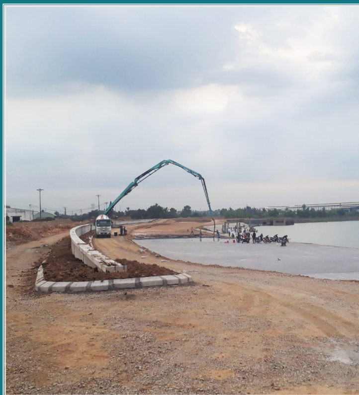
Bê tông hóa đê hữu Kinh Môn, huyện Kim Thành Concretize the Kinh Mon right dyke, Kim Thanh district
