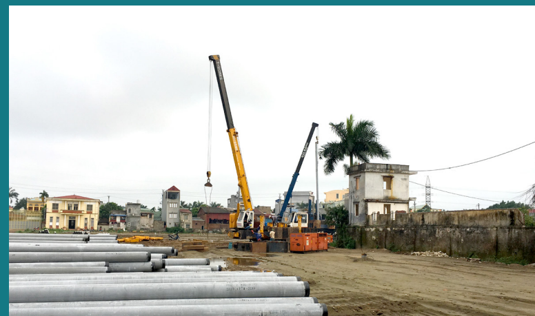
Hình ảnh thi công tại công trường dự án Việt Phát South City Viet Phat South City Project construction site working
