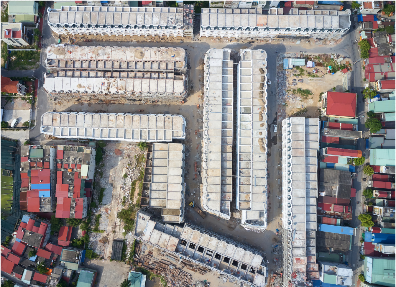
Công trường Dự án Việt Phát South City Viet Phat South City Project construction site
