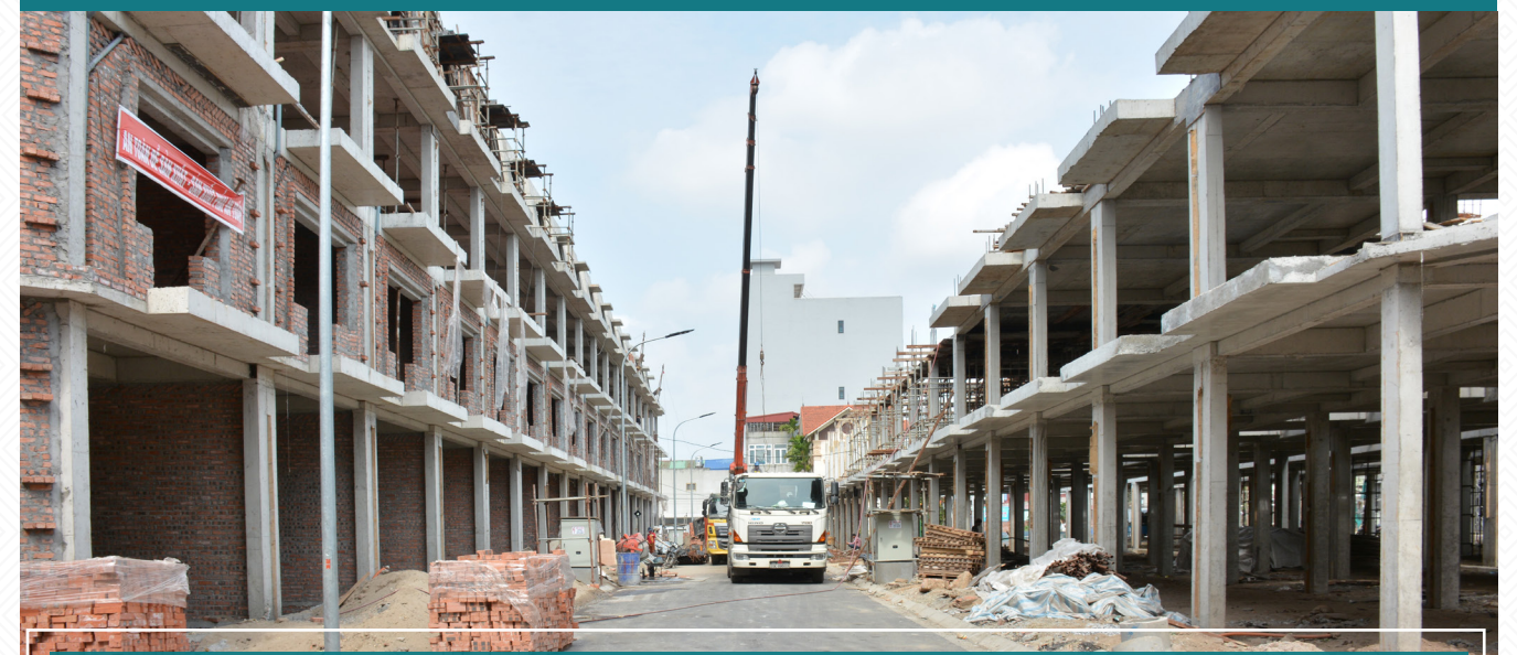
Công trường Dự án Việt Phát South City Viet Phat South City Project construction site
