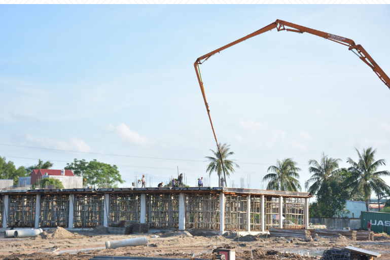
Thi công đổ bê tông sàn tầng 2 Dự án Việt Phát South City Viet Phat South City Project second floor concrete work
