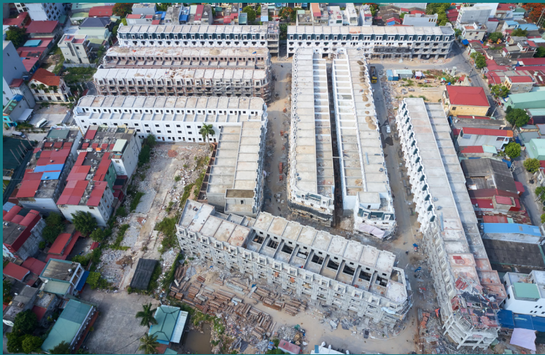
Hình ảnh thi công tại công trường dự án Việt Phát South City Viet Phat South City Project construction site working image
