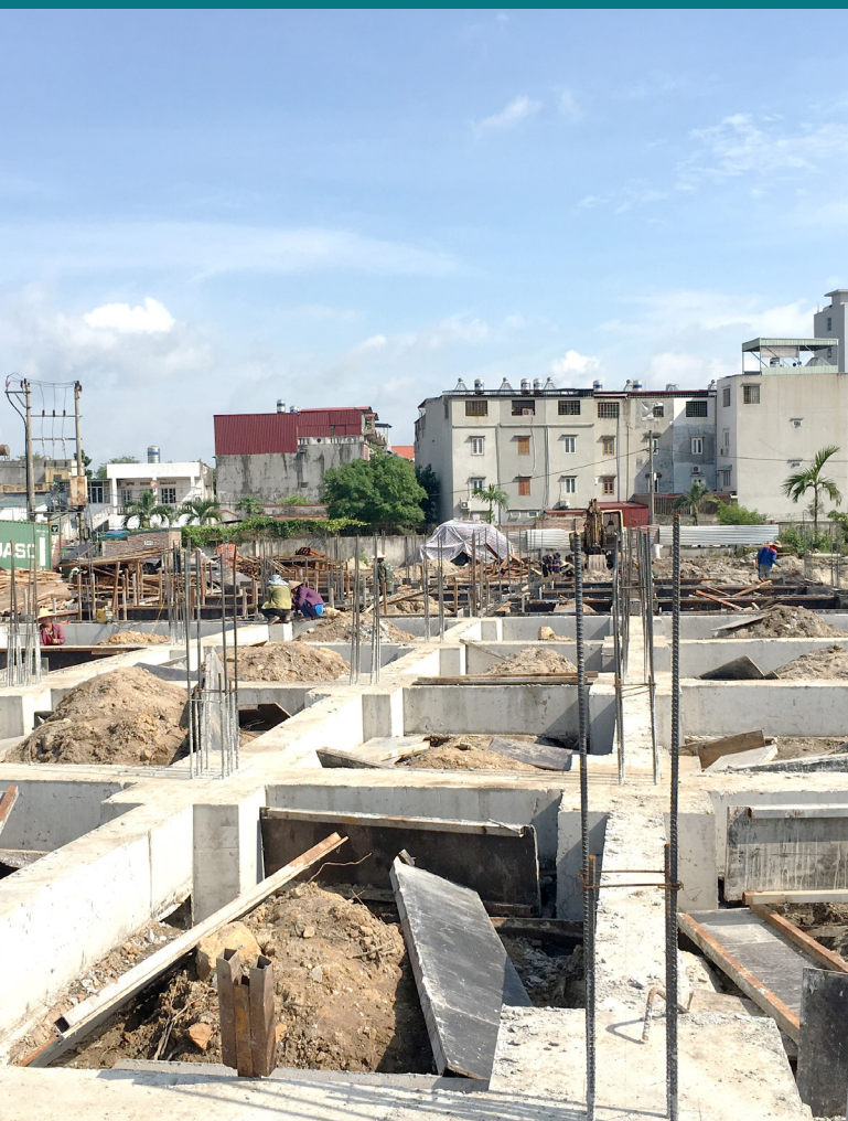
Hình ảnh thi công tại công trường dự án Việt Phát South City Viet Phat South City Project construction site working image
