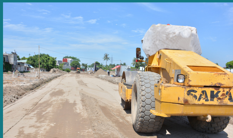
Thi công lu nền đường trong dự án Nội bộ dự án Viet Phat South City Project's internal road foundation construction
