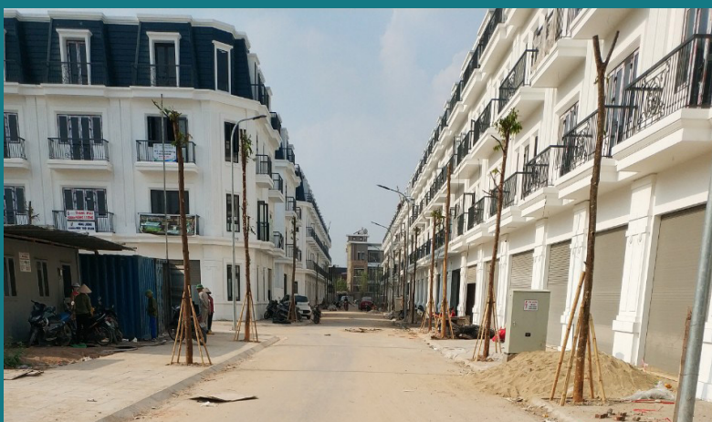
Hình ảnh thi công tại công trường dự án Việt Phát South City Viet Phat South City Project construction site working image
