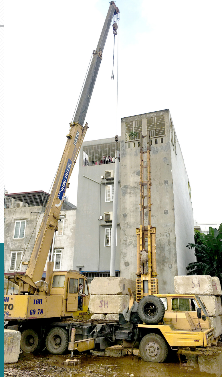
Hình ảnh thi công tại công trường dự án Việt Phát South City Viet Phat South City Project construction site working image
