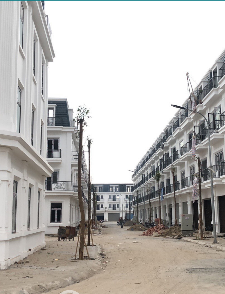
Hình ảnh thi công tại công trường dự án Việt Phát South City Viet Phat South City Project construction site working image
