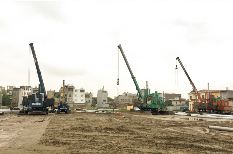
Hình ảnh thi công tại công trường dự án Việt Phát South City Viet Phat South City Project construction site working image
