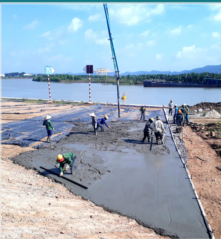
Bê tông hóa đê hữu Kinh Môn, huyện Kim Thành Concretize the Kinh Mon right dyke, Kim Thanh district
