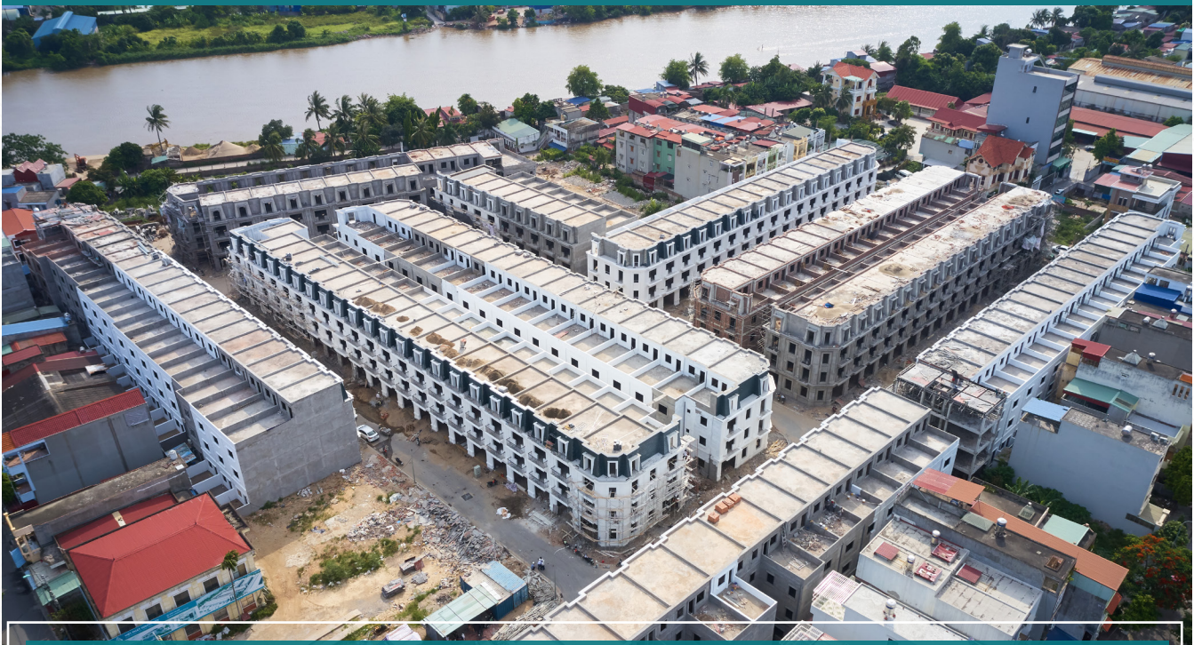
Công trường Dự án Việt Phát South City Viet Phat South City Project construction site
