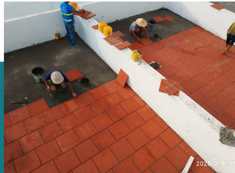
Hình ảnh thi công tại công trường dự án Việt Phát South City Viet Phat South City Project construction site working image
