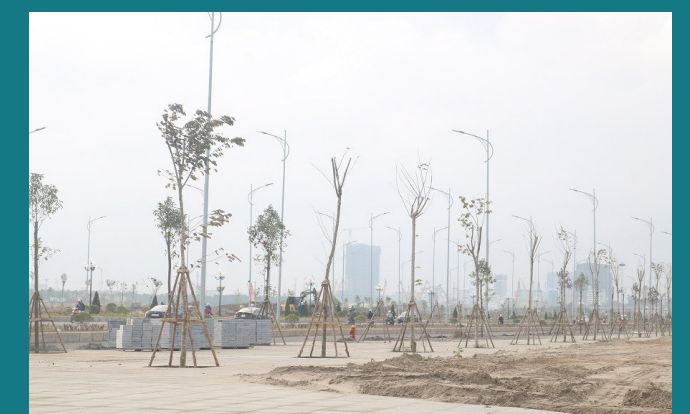
Công trường Dự án Project construction site
