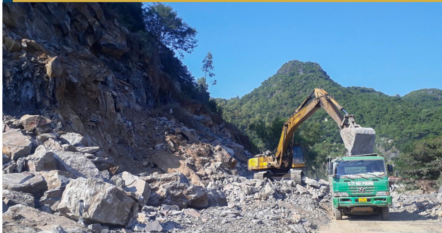
Ô tô Hyundai 15t thi công gói thầu số 07 xây dựng thuộc dự án đầu tư cải tạo, nâng cấp đường 356 đoạn từ ngã 3 áng sỏi đến tổ dân phố 2, thị trấn Cát Bà
