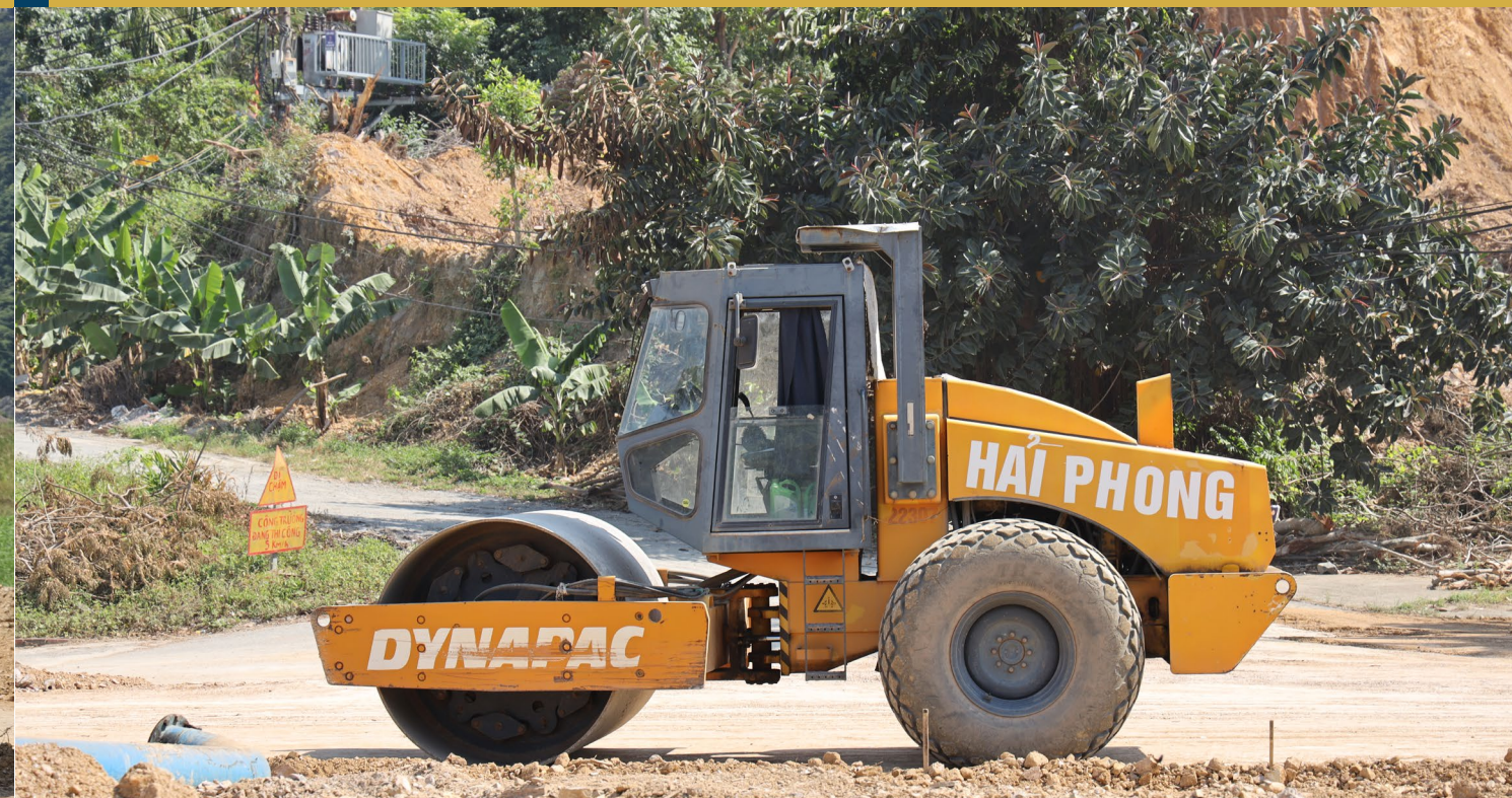
Xe lu rung Dynapac thi công gói thầu số 27 dự án Đầu tư cải tạo nâng cấp đường 356 đoạn qua xã Xuân Đám
