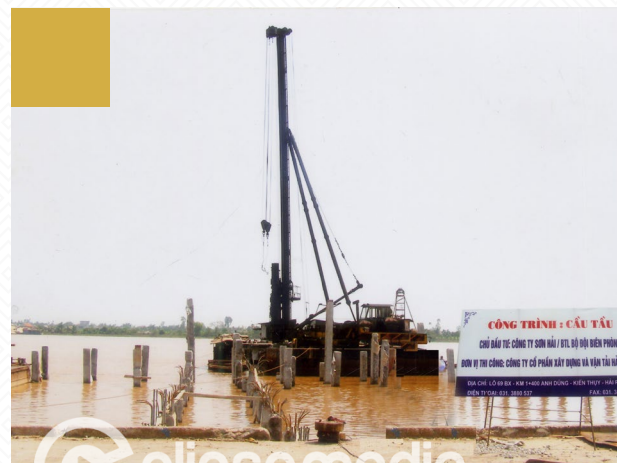
Thi công đóng cọc bê tông
