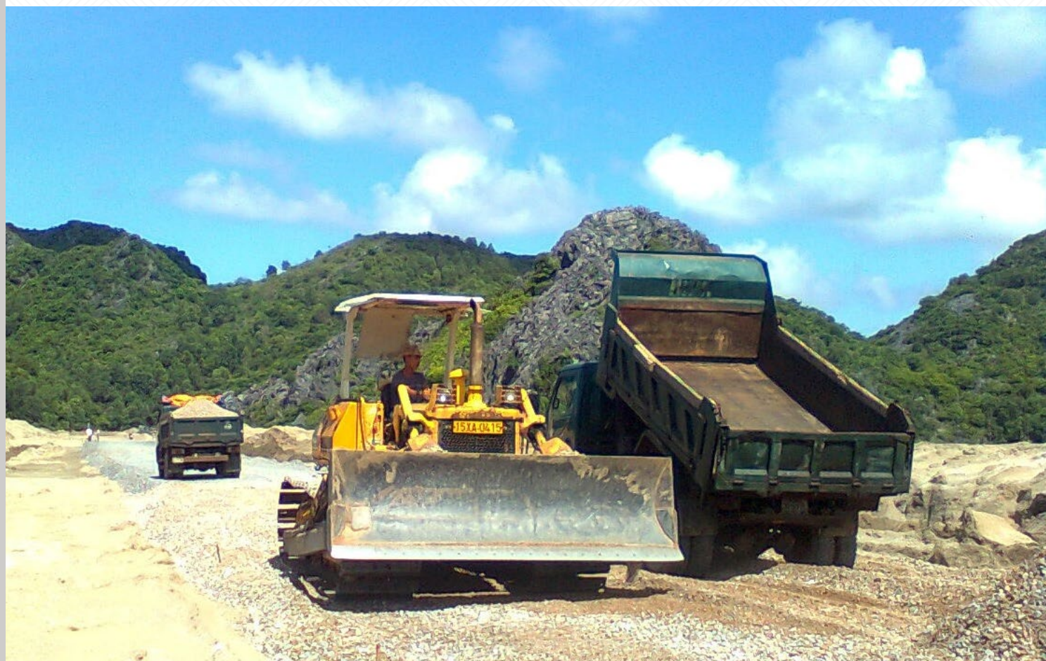
Máy ủi D40 thi công gói thầu Đường giao thông và các công trình kỹ thuật khác thuộc dự án Đầu tư công trình cơ sở hạ tầng trung tâm dịch vụ hậu cần & phát triển thủy sản Trân Châu Cát Bà
