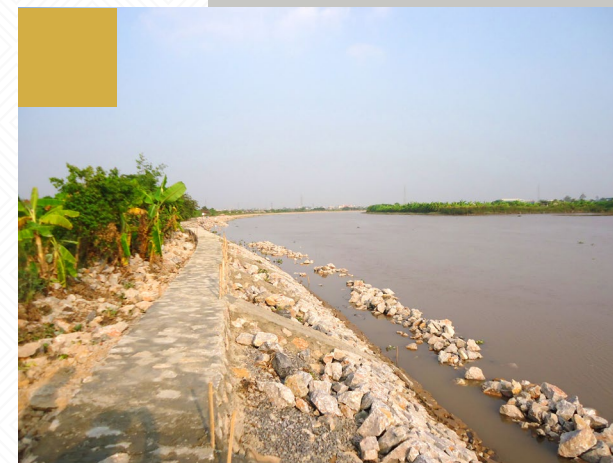
Lát mái kè
