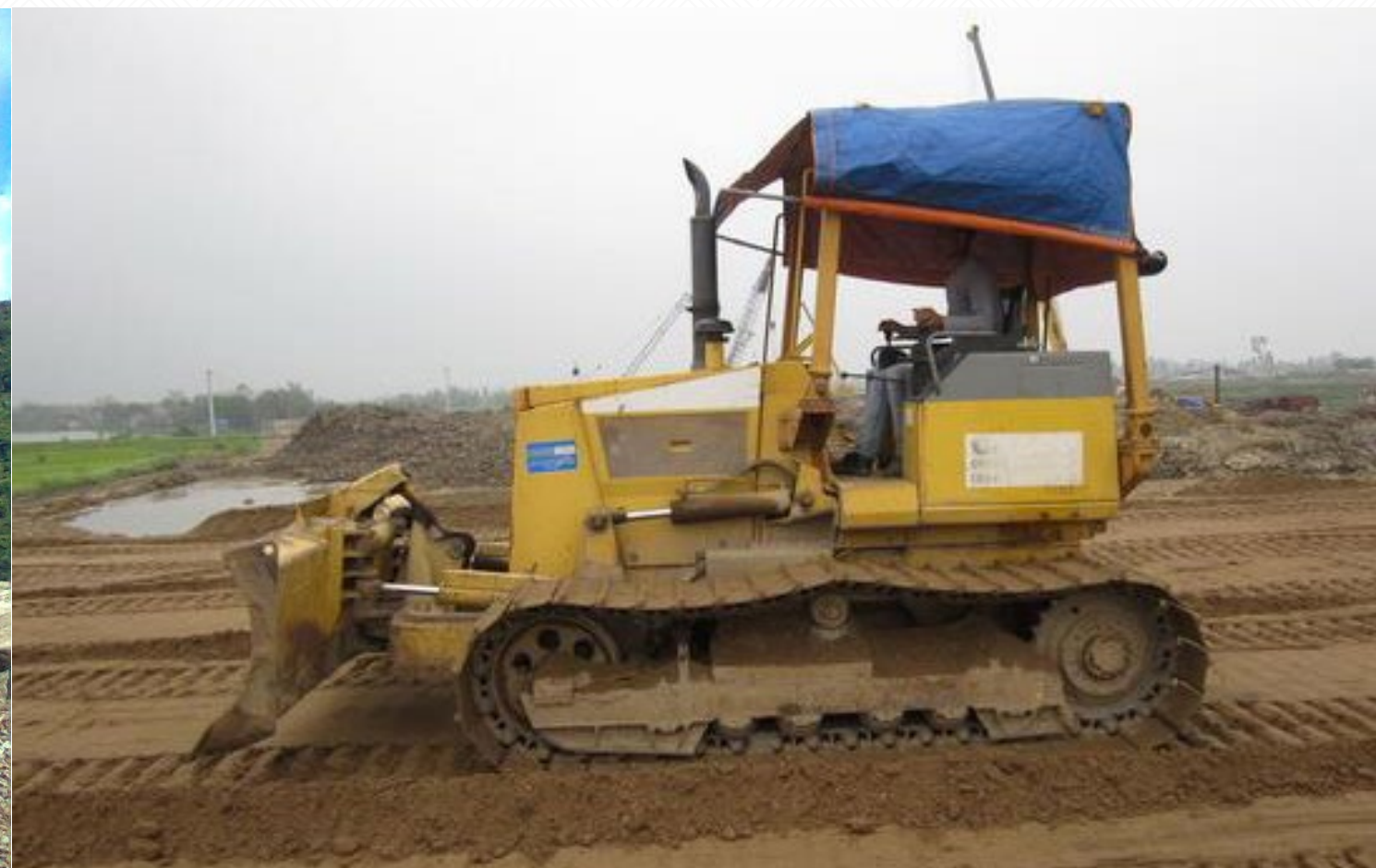
Máy ủi D40 thi công gói thầu 3.35 Đường trục chính Bắc Nam khu đô thị Bắc Sông Cẩm - Hải Phòng
