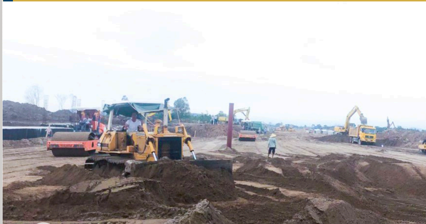
Máy ủi D40 thi công gói thầu 3.35 Đường trục chính Bắc Nam khu đô thị Bắc Sông Cẩm - Hải Phòng
