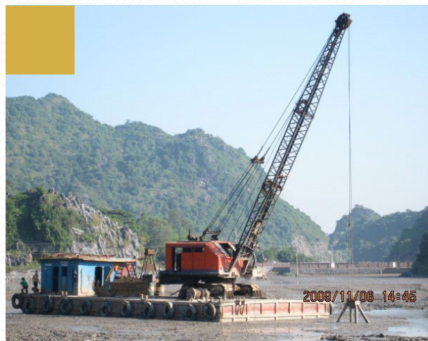
Nạo vét bằng máy đào gầu dây khu vực gần bờ
