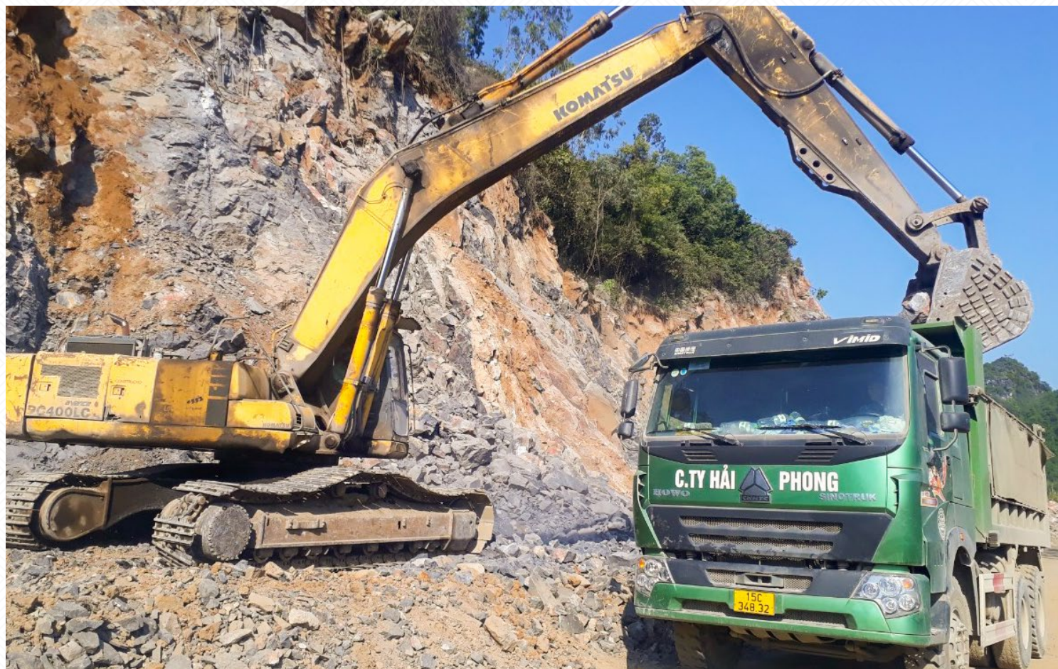
Máy xúc KOMATSU 400-6; Ô tô Howo 15t thi công gói thầu số 07 xây dựng thuộc dự án đầu tư cải tạo, nâng cấp đường 356 đoạn từ ngã 3 áng sỏi đến tổ dân phố 2, thị trấn Cát Bà
