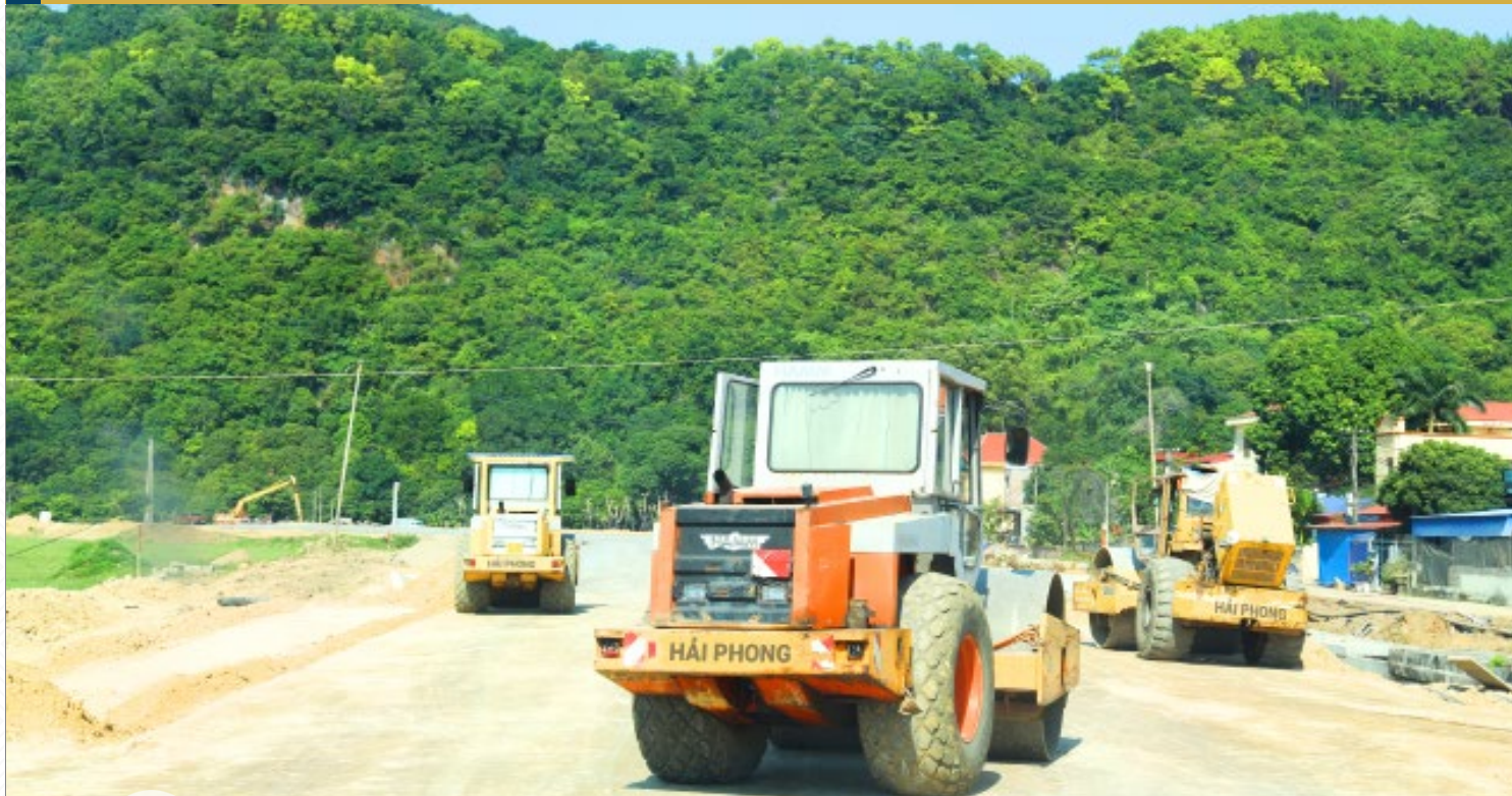
Máy san HAMM 4011 thi công gói thầu số 27 dự án Đầu tư cải tạo nâng cấp đường 356 đoạn qua xã Xuân Đám
