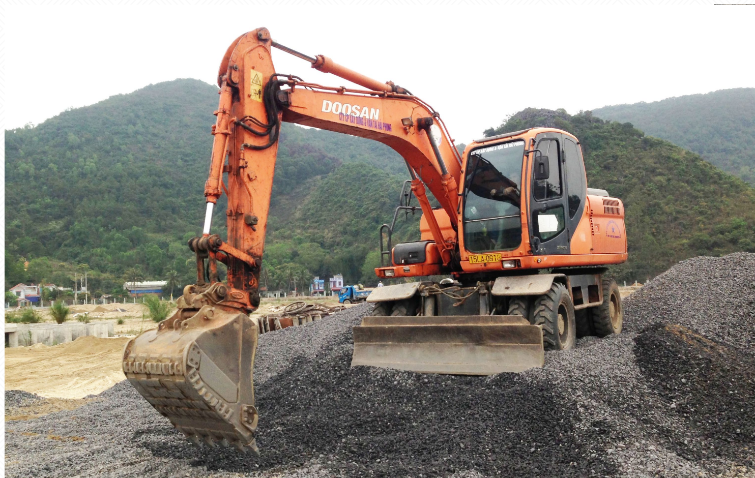
Máy xúc DOOSAN DX140 thi công gói thầu Đường giao thông và các công trình kỹ thuật khác thuộc dự án Đầu tư công trình cơ sở hạ tầng trung tâm dịch vụ hậu cần & phát triển thủy sản Trần Châu Cát Bà
