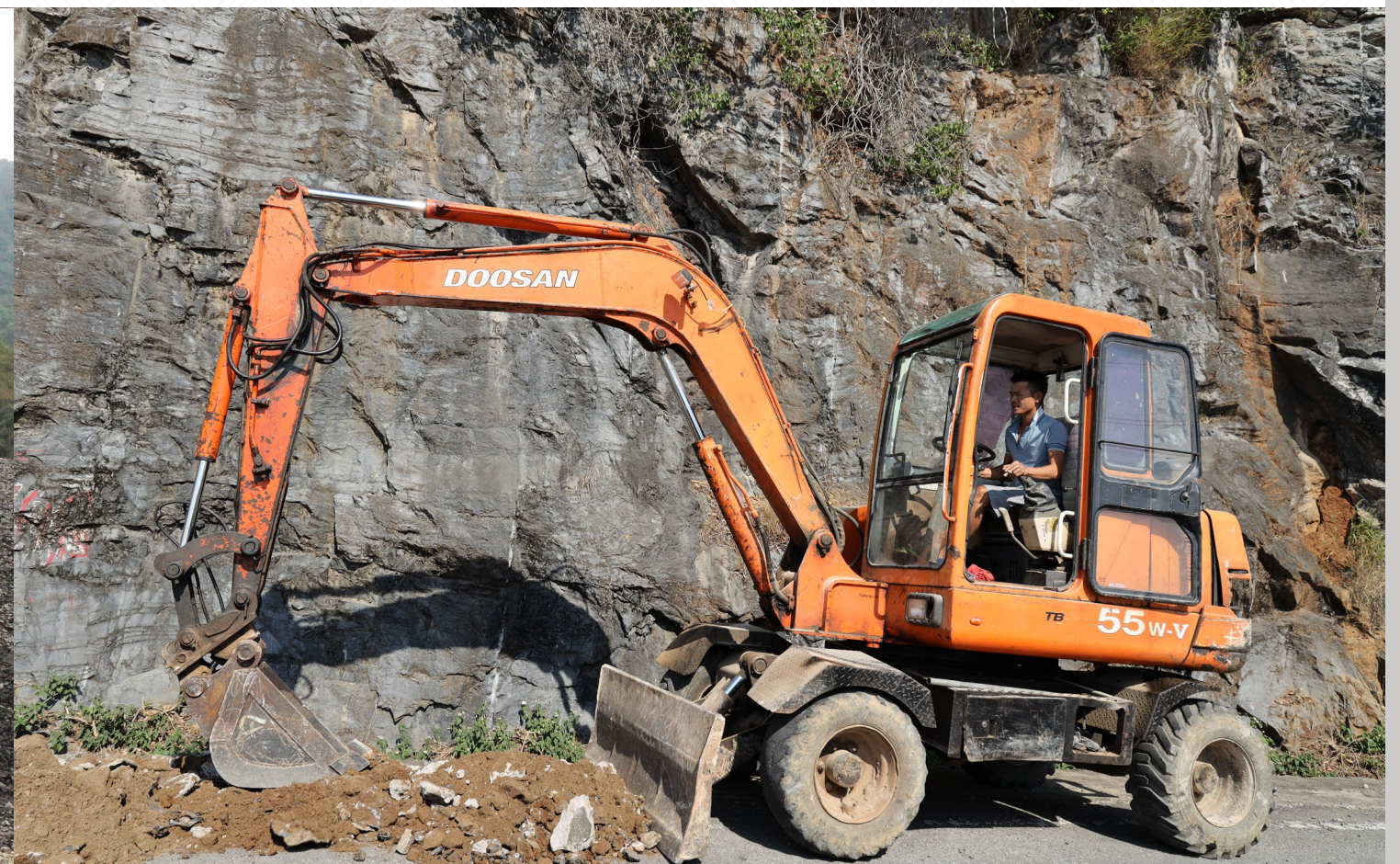
Máy xúc DOOSAN 55 thi công gói thầu Cải tạo, nâng cấp đường 356 đoạn từ Mốc Trắng đến ngã 3 Hiền Hào - Cát Bà
