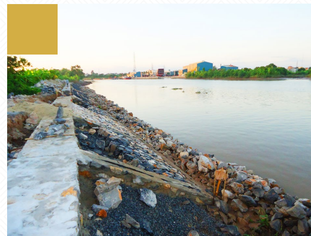
Xây cơ kè
