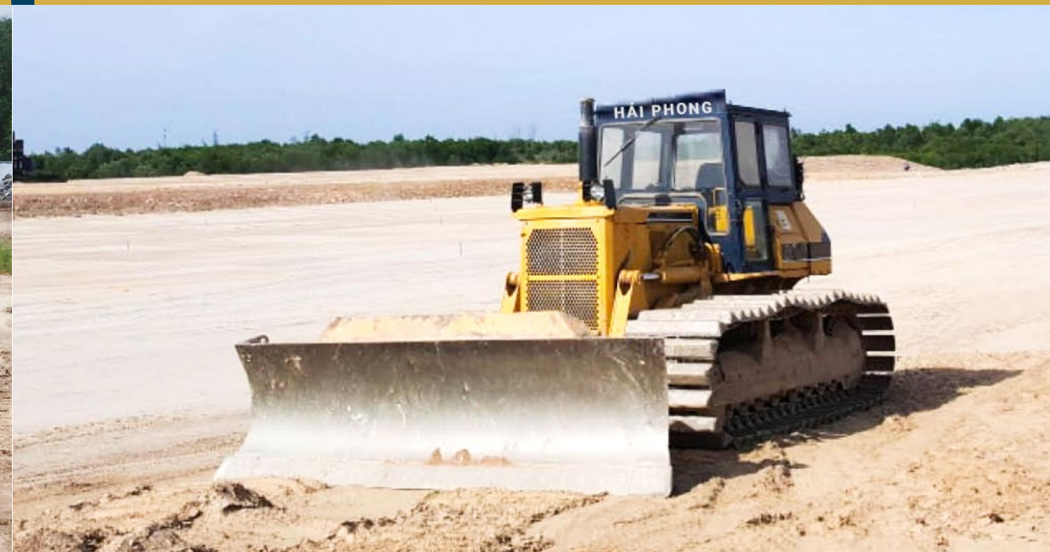
Máy ủi KOMATSU D41 thi công san lấp sau kè Gói thầu 19B - Xây dựng kè sông Cấm & kè bến cảng du lịch, Khu Đô thị Bắc Sông Cấm - Hải Phòng
