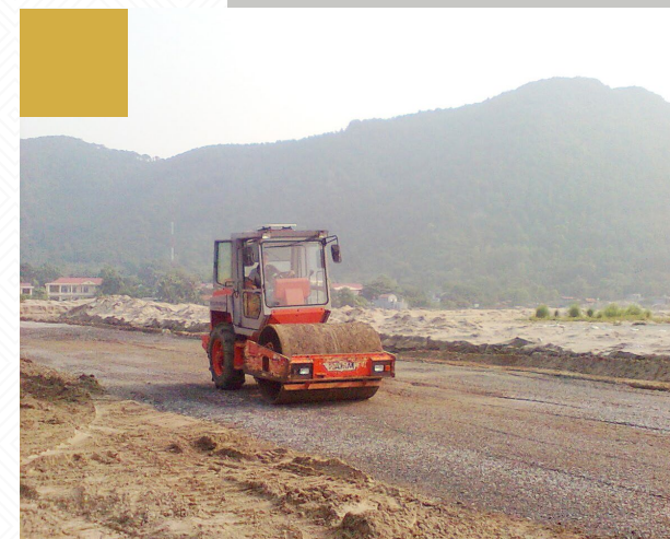
Thi công lu nền đường
