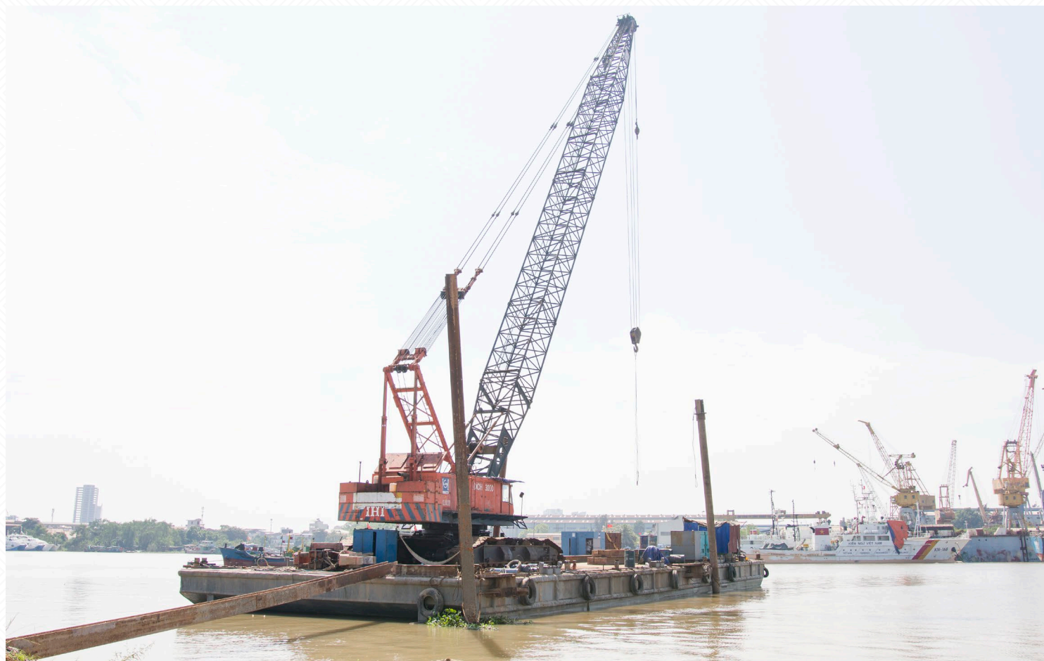
Cầu trục 150t; pông-tông 1400t đóng Cừ Larsen Sw 840 Gói thầu 19B - Xây dựng kè sông Cấm & kè bến cảng du lịch, Khu Đô thị Bắc Sông Cấm - Hải Phòng
