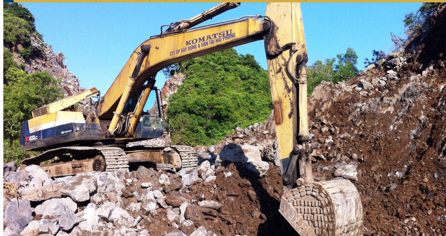
Máy xúc Komatsu 400-5 thi công gói thầu XL1 đoạn qua xã Trần Châu và thị trấn Cát Bà thuộc dự án đầu tư cải tạo, nâng cấp đường 356
