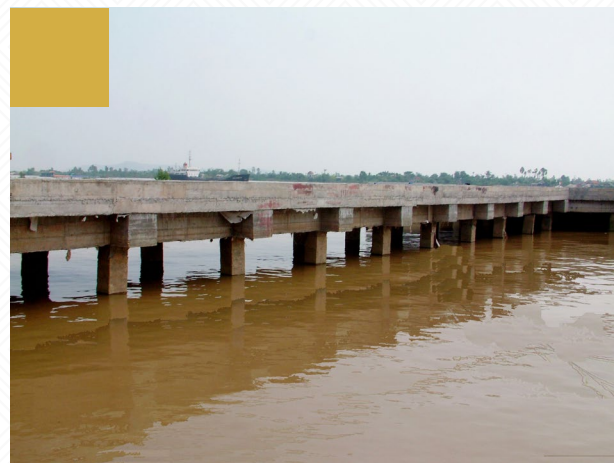
Thi công đóng cọc bê tông
