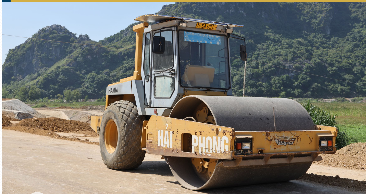
Xe lu rung HAMM 15SA-0312 thi công Gói thầu số 27 dự án Đầu tư cải tạo nâng cấp đường 356 đoạn qua xã Xuân Đám
