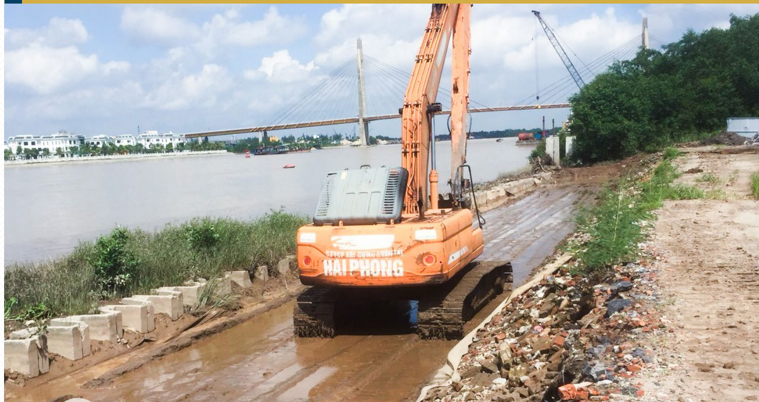
Máy xúc DOOSAN DX220 thi công san lấp sau kè Gói thầu 19B - Xây dựng kè sông Cấm & kè bến cảng du lịch, Khu Đô thị Bắc Sông Cấm - Hải Phòng
