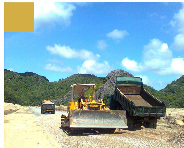
Thi công san gạt nền đường
