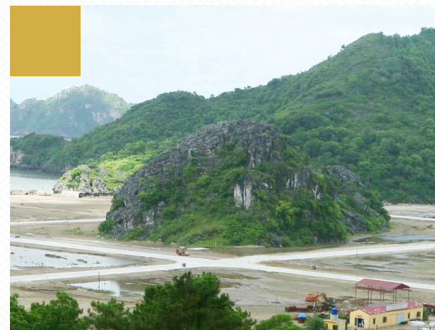
Thi công đường bê tông
