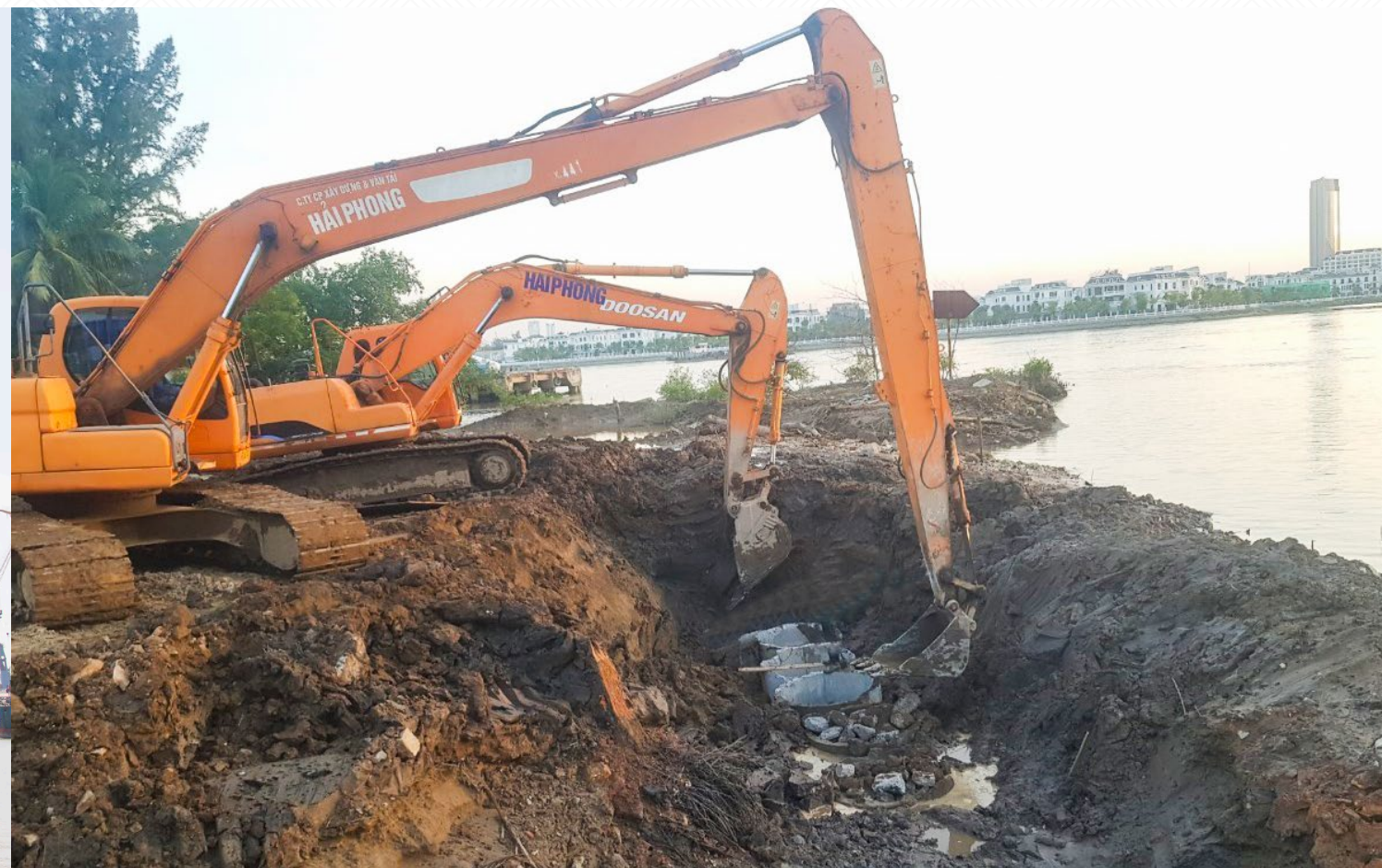
Máy xúc DOOSAN DX225; DOOSAN DX300 thi công đặt cống bi Gói thầu 19B - Xây dựng kè sông Cấm & kè bến cảng du lịch, Khu Đô thị Bắc Sông Cấm - Hải Phòng
