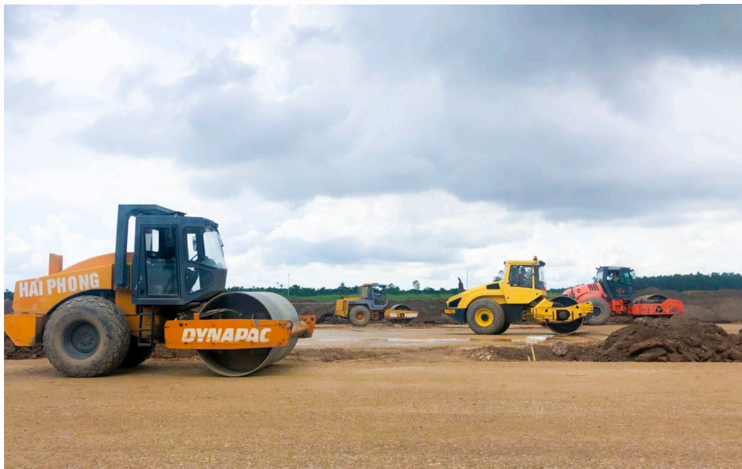
Dàn xe lu thi công gói thầu số 3.35: Xây dựng đường trục chính Bắc Nam thuộc dự án Khu đô thị Bắc Sông Cẩm
