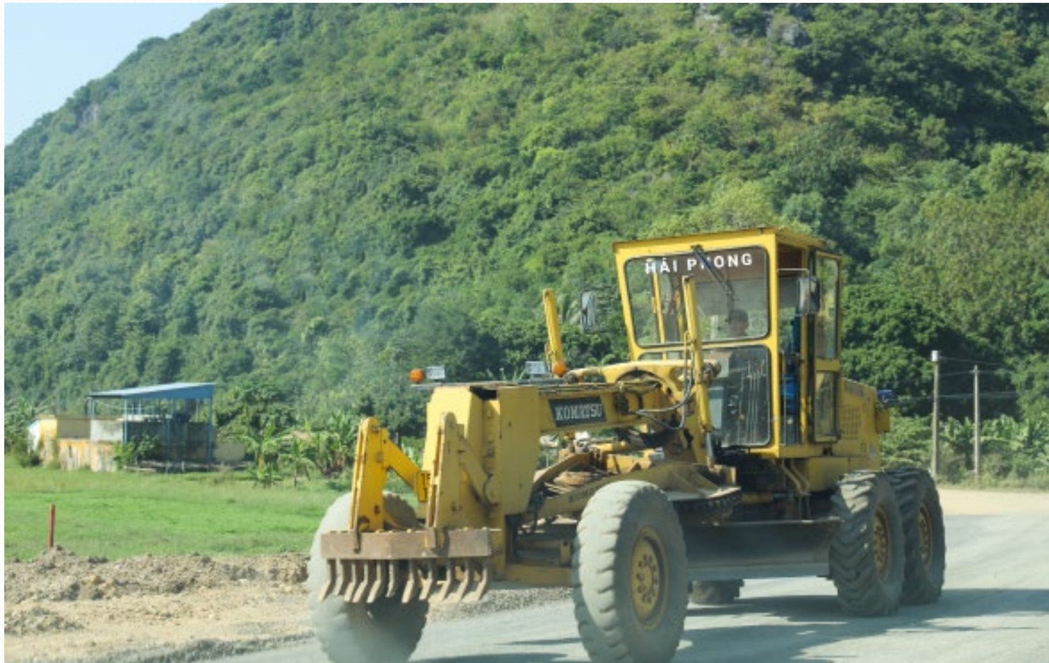
Máy san KOMATSU thi công Gói thầu số 27 dự án Đầu tư cải tạo nâng cấp đường 356 đoạn qua xã Xuân Đám
