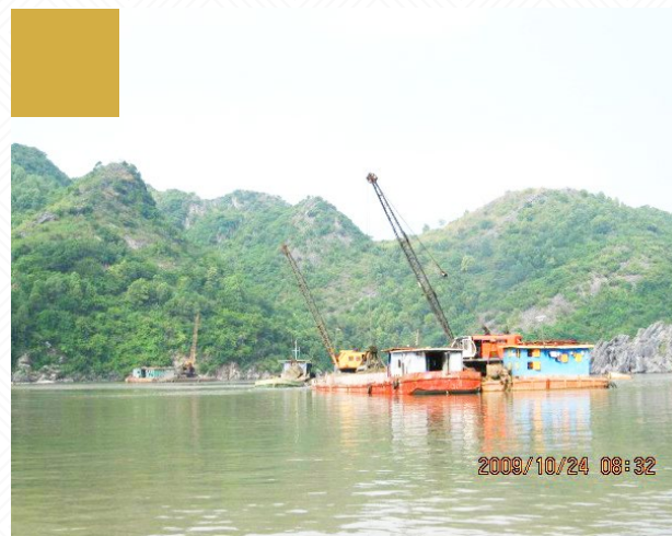
Nạo vét bằng máy đào gầu dây
