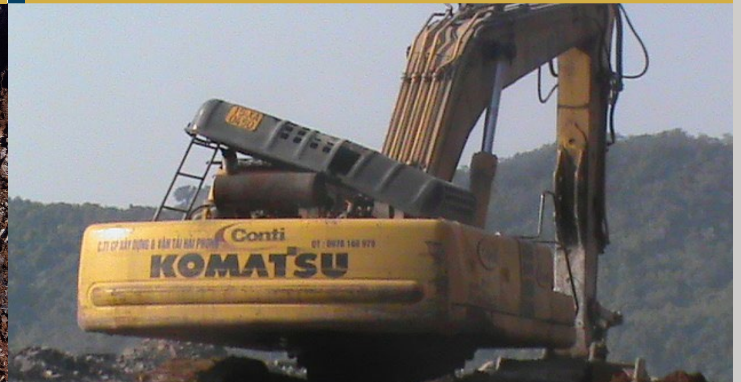
Máy xúc Komatsu 400-6 thi công gói thầu XL1 đoạn qua xã Trần Châu và thị trấn Cát Bà thuộc dự án đầu tư cải tạo, nâng cấp đường 356
