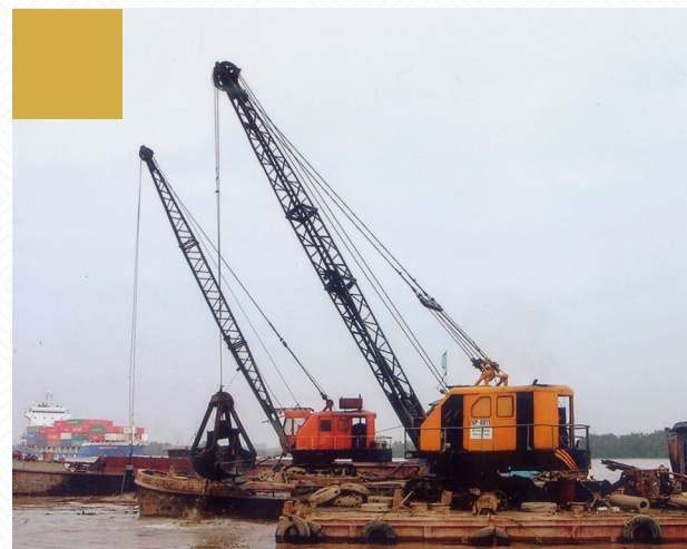
Công tác chuẩn bị thi công nạo vét
