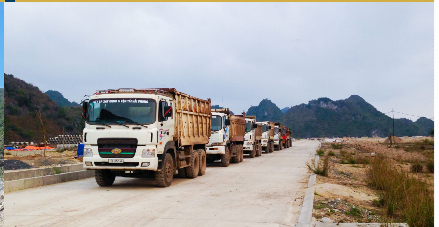
Dàn xe thi công Dự án Đầu tư xây dựng công trình cơ sở hạ tầng Trung tâm dịch vụ hậu cần và phát triển thủy sản Trân Châu - Cát Bà
