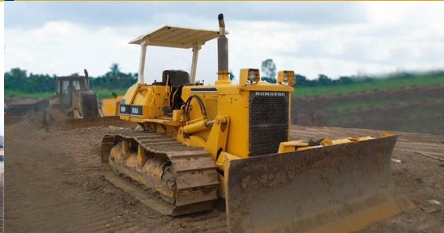
Máy ủi D41 thi công gói thầu 3.35 Đường trục chính Bắc Nam khu đô thị Bắc Sông Cẩm - Hải Phòng
