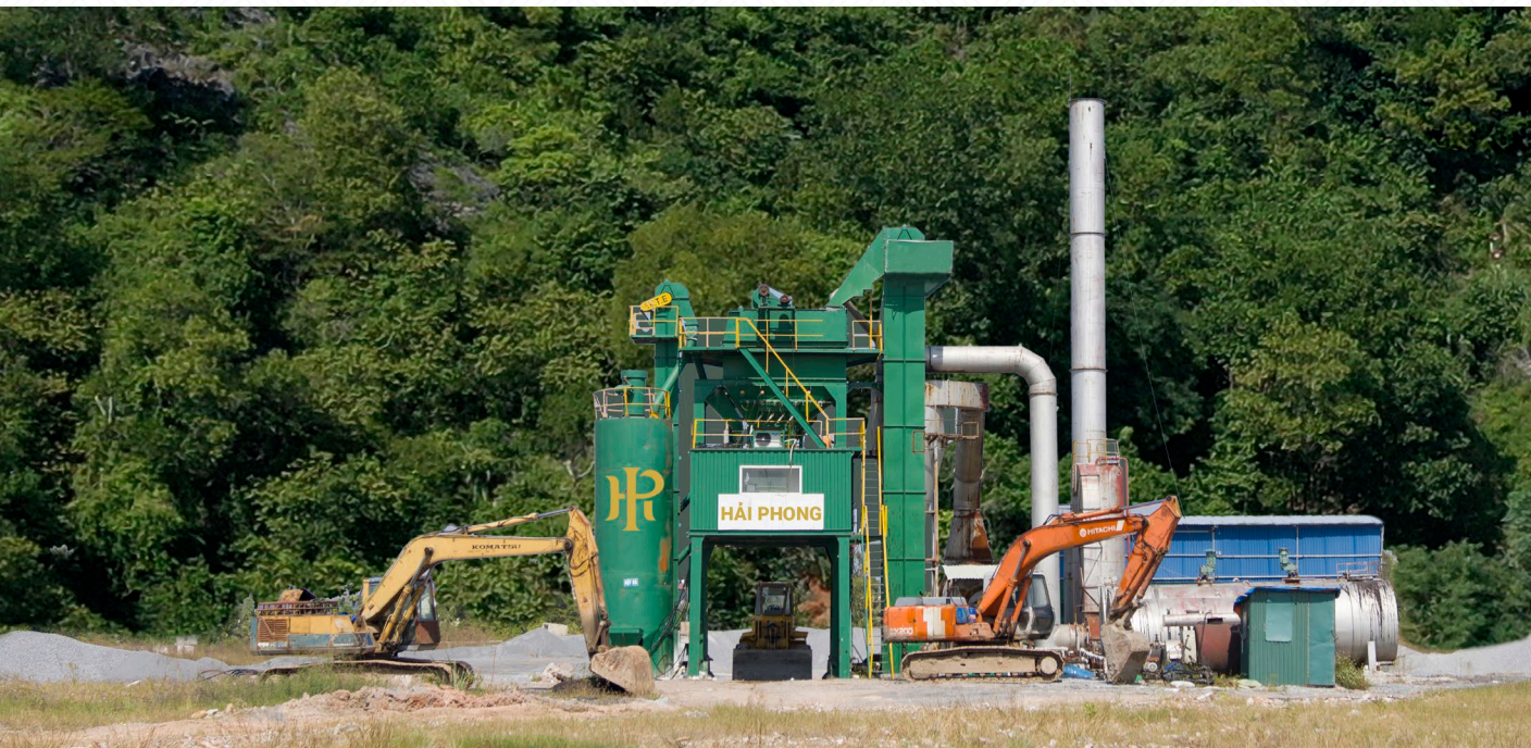
CÁT BÀ Trạm bê tông asphalt công suất 120 tấn/h Xã Hiền Hào - Huyện Cát Hải - Hải Phòng
