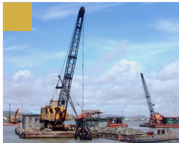
vận chuyển đất đắp đi bằng tàu chở đất chuyên dùng 400 tấn
